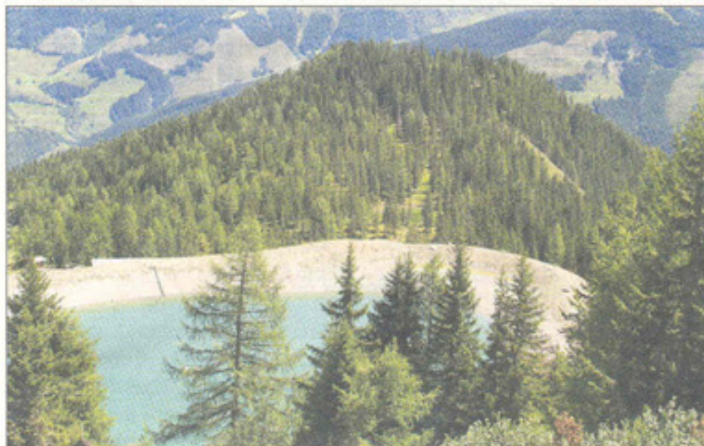
Der neu errichtete Speicherteich im Bereich der Hochalm fasst 65.000 Kubikmeter Wasser.
